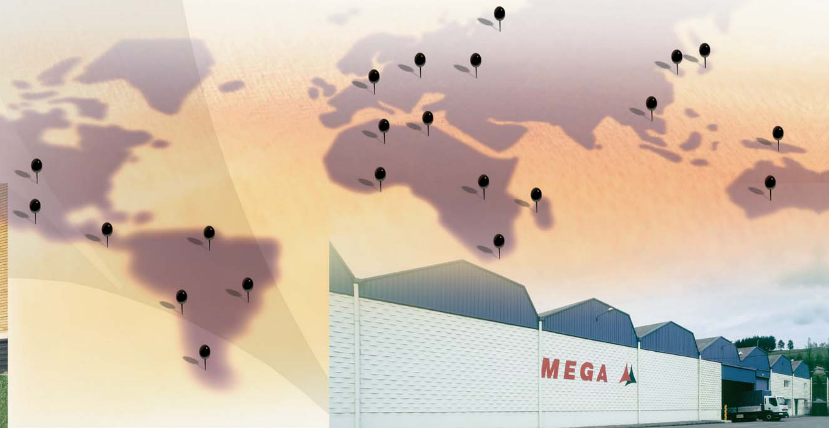
Instalación de pintura, almacén y expediciones. BERRIZ.
