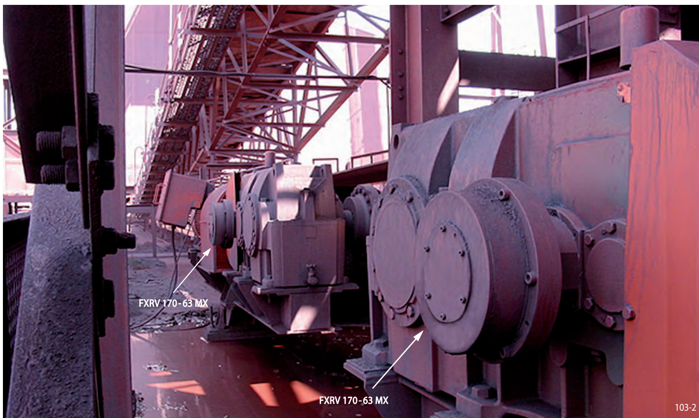
Instalación de cintas transportadoras para mineral de hierro en Sudáfrica accionadas por tres reductores con antirretrocesos FXRT 170 - 63 MX de RINGSPANN.
